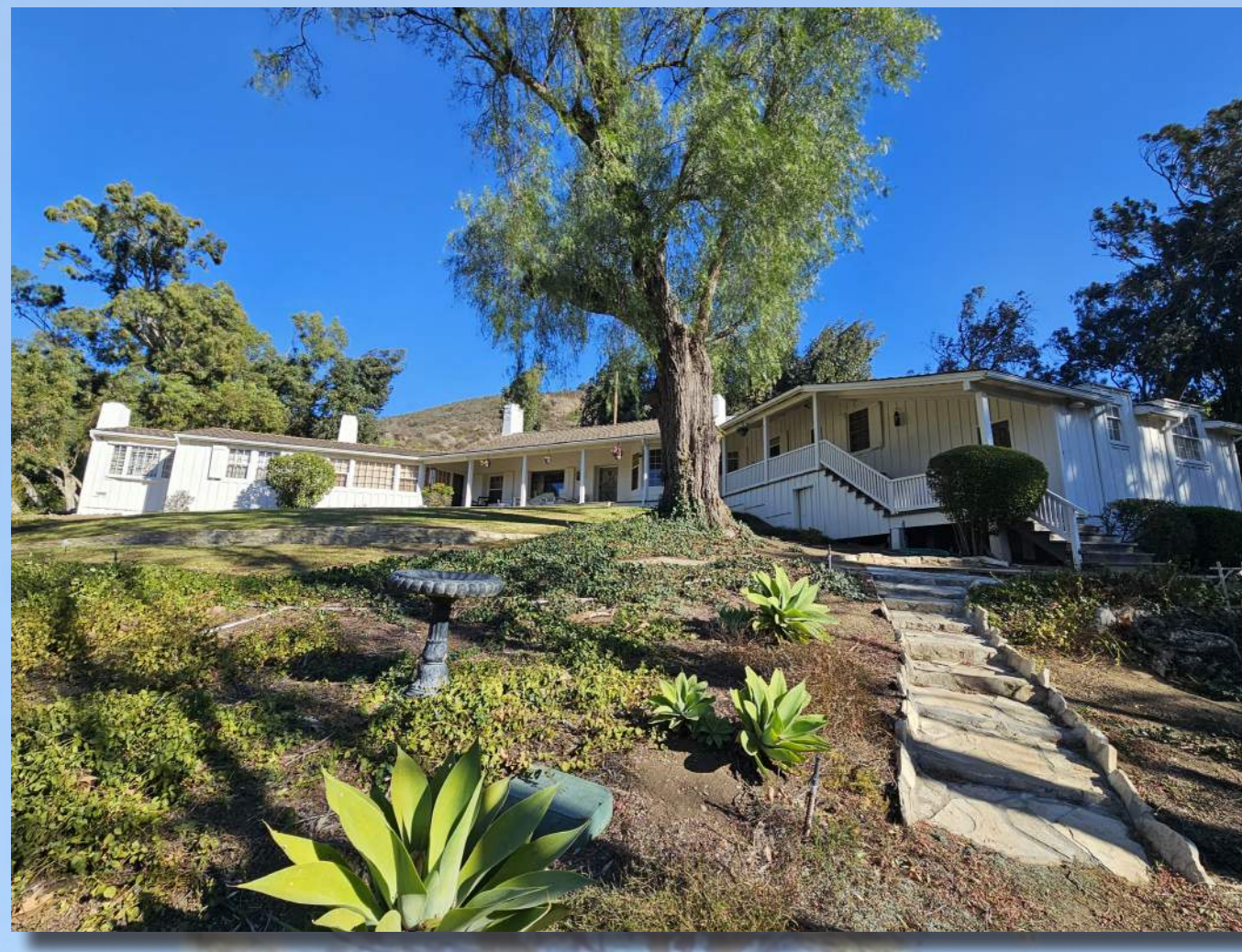
REPLACE ROOF (2026 Est. Cost $88,000)
