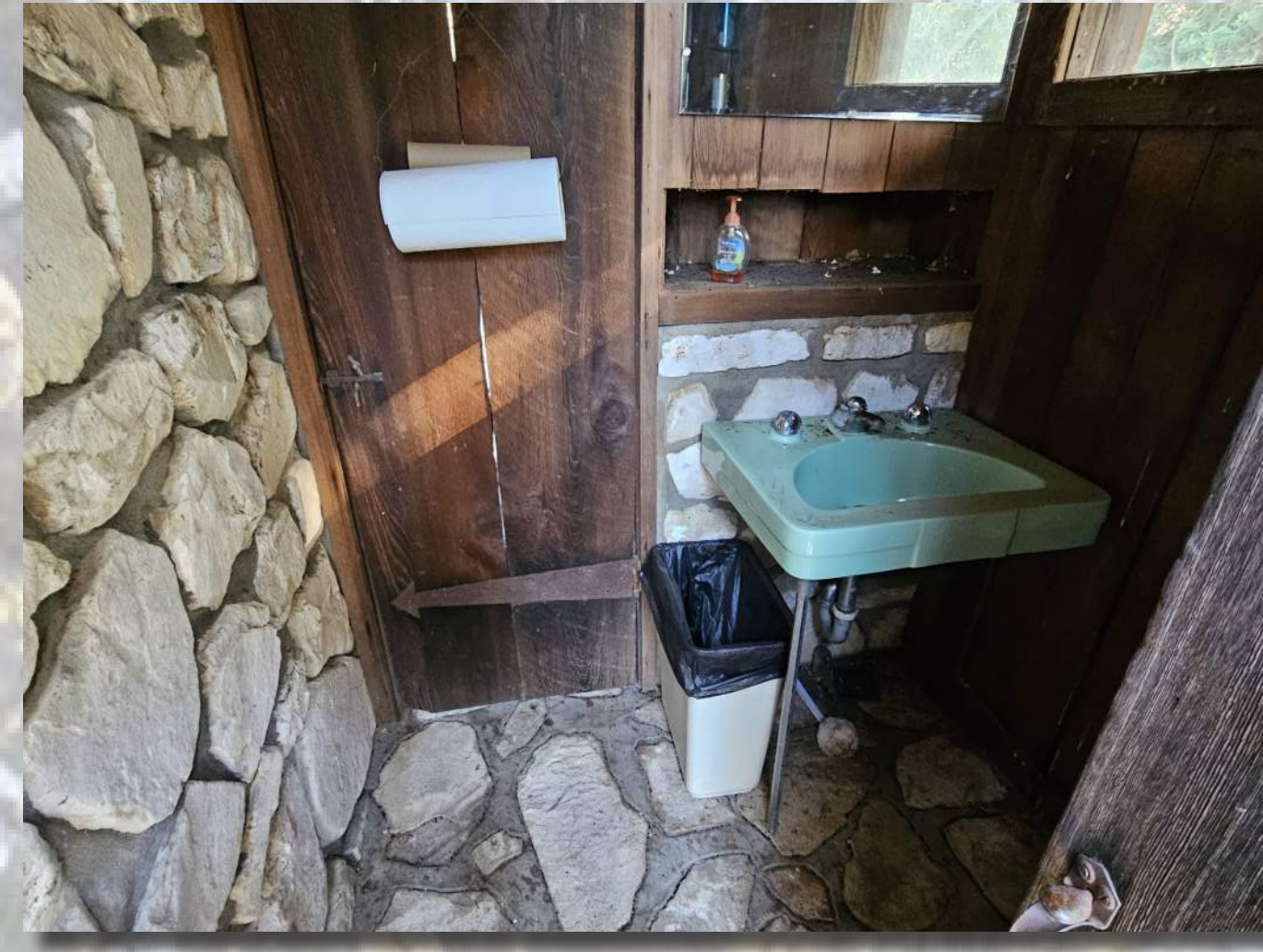
REPAIR/RESTORE BATHROOM (2026 Est. Cost $4,500)
